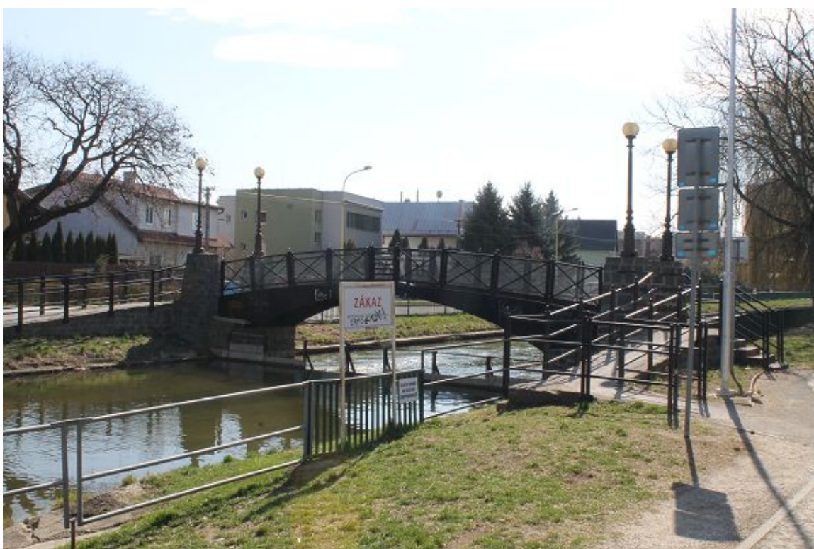
Mostík pre peších na Tomášikovej ulici s dočasnou prehrádzkou a s rampami.
