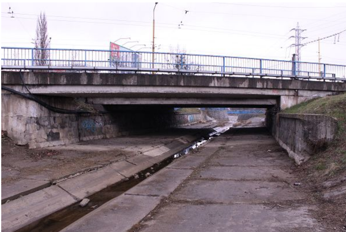
Most na Hlinkovej ulici.
