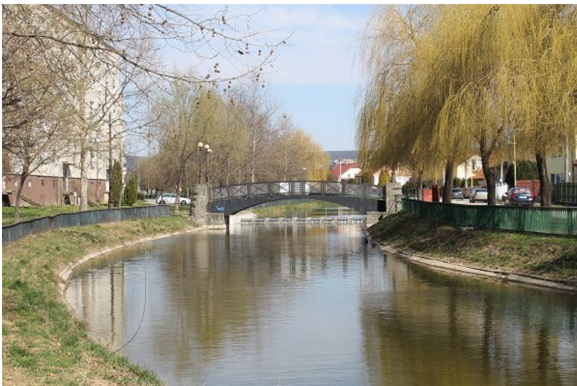
Pohľad na mostík pre pešách na ulici Čárskeho, vpravo je ulica Ťahanovské riadky.
