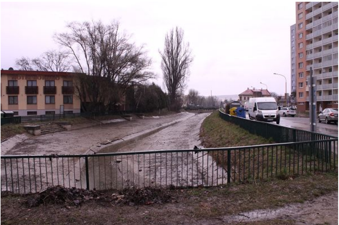
Pohľad z miesta prehradenia koryta zhybkou smerom na sever, vľavo hotel Rokoko, v pozadí prehrádzka a most na ulici Slovenskej jednoty.
