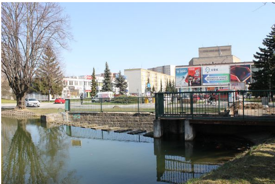
Výpustný objekt z opačné strany, v pozadí Hutnícka ulica a Jumbo centrum.
