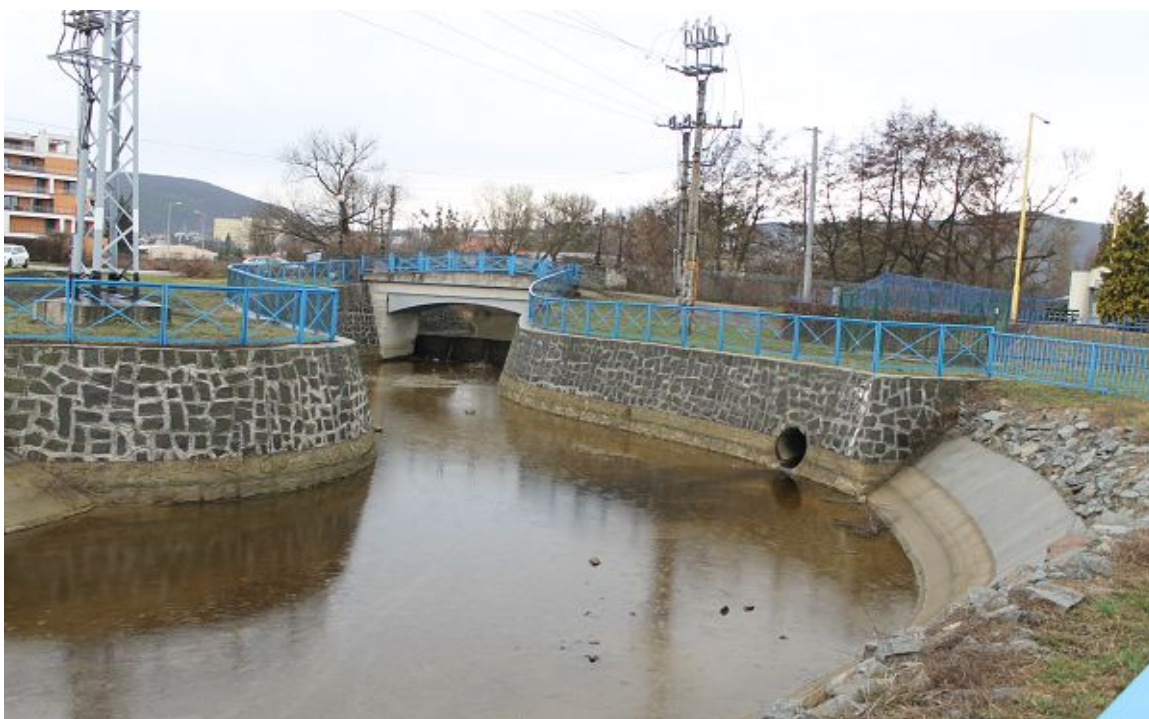
Začiatok Mlynského náhonu, v strede prehrádzka, ktorá oddeluje vodnú nádrž Ryba od Mlynského náhonu, vpravo prívod vody potrubím DN 1000 z Hornádu cez nâpustný objekt.
