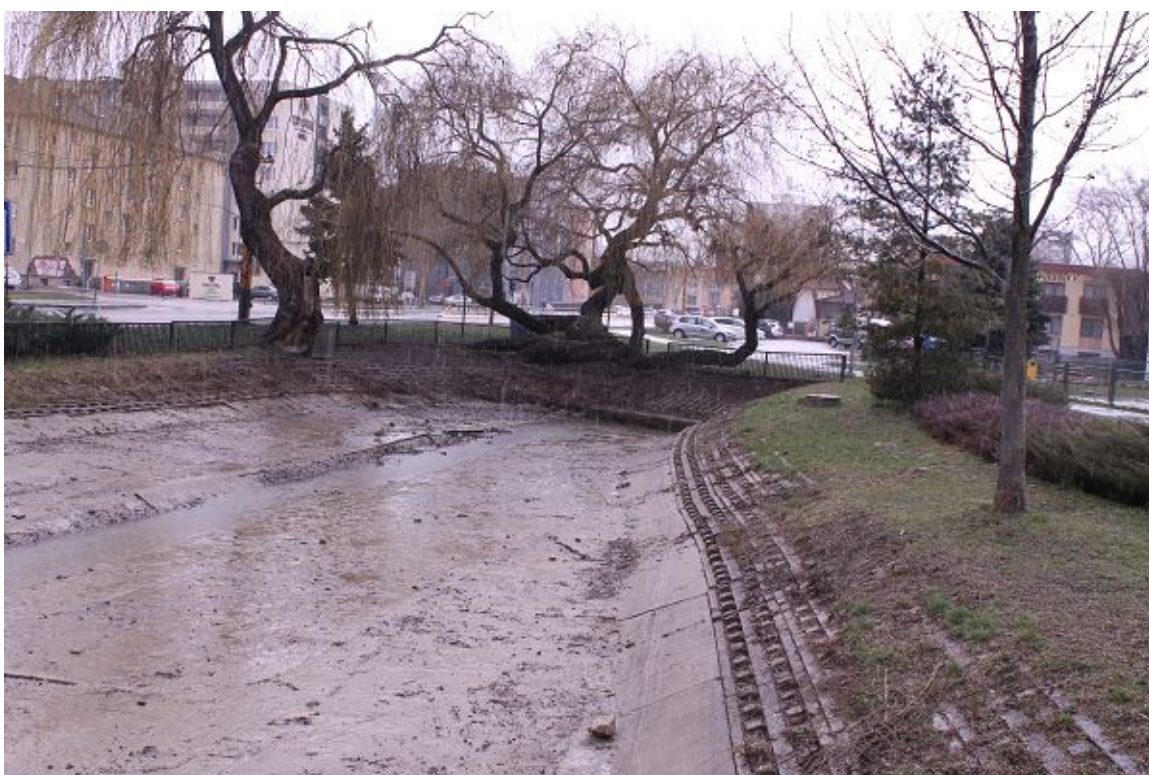
Pohľad na prehradenie koryta zhybkou z juhu, v spodnej časti koryta je vyústenie dvoch rúr DN 600.
