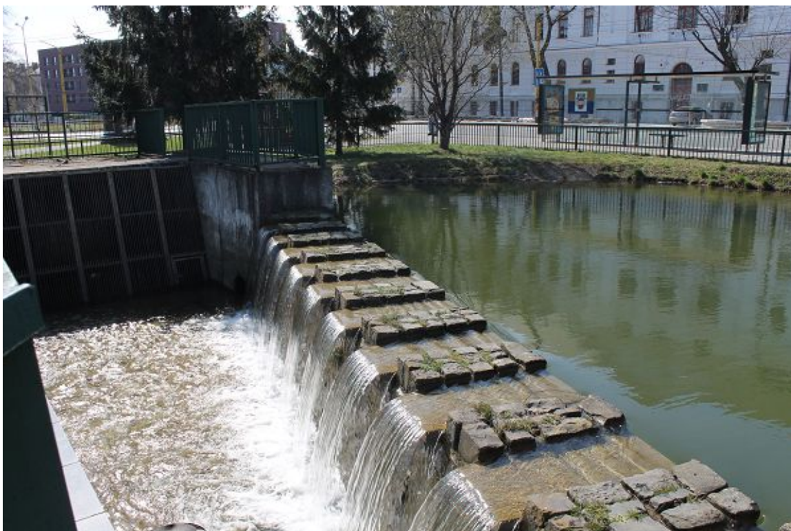
Výpustný objekt s česlami na zachytávanie nečistôt.
