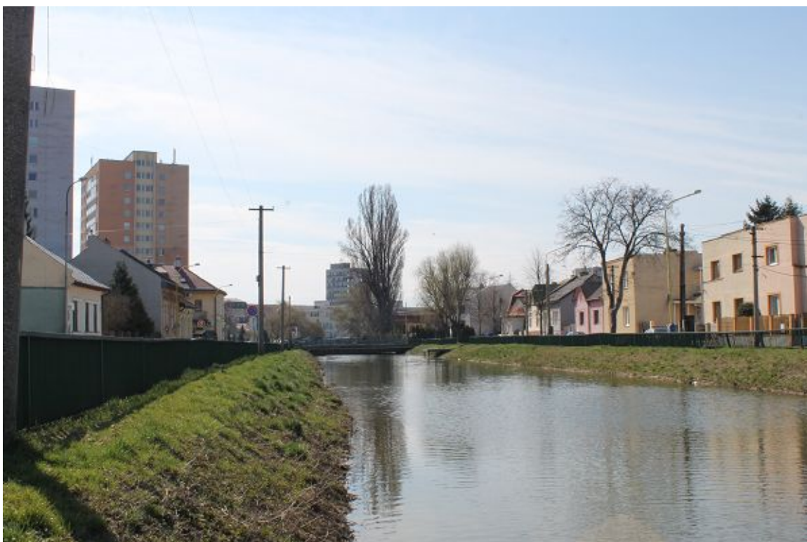
Pohľad na most na ulici Slovenskej jednoty, vľavo je ulica Ťahanovské riadky.
