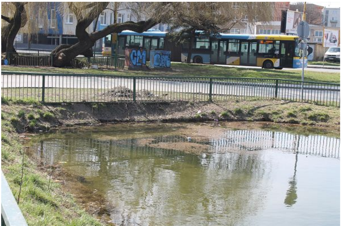
Prehradenie vodného toku a zhybka, pohľad zo severu.
