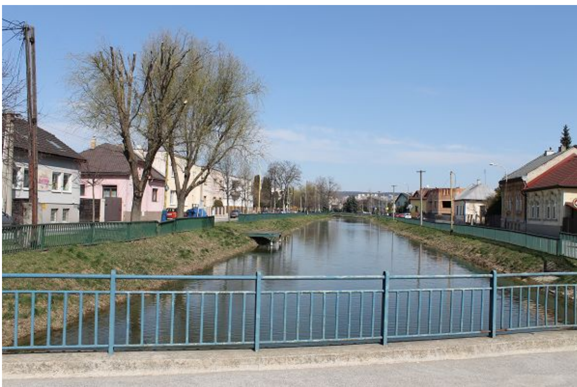
Pohľad z mosta na ulici Slovenskej jednoty smerom na sever, vpravo je ulica Ťahanovské riadky.
