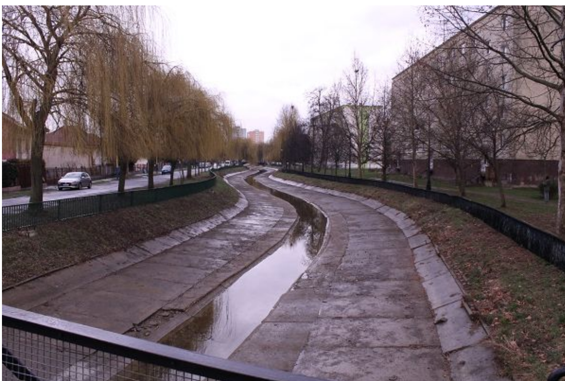
Pohľad z mostíka pre peších na Čárskeho ulici smerom na juh, vľavo je ulica Ťahanovské riadky.
